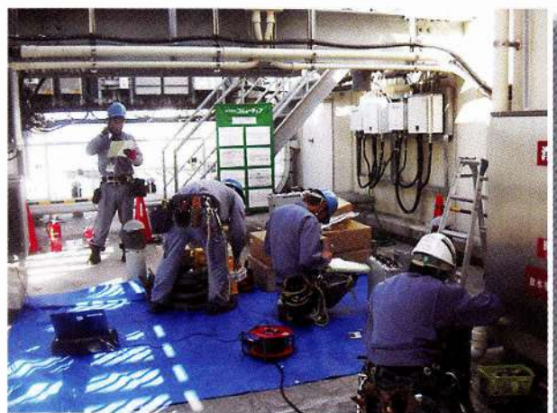
SBM工事 (J棟屋上)
