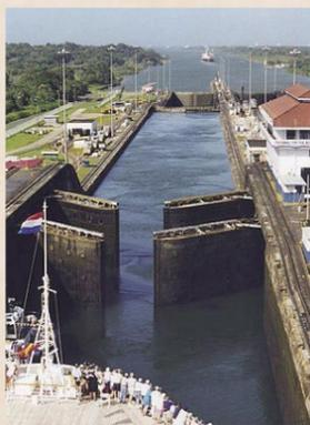
先行の船が入っている第1チャンパーの水位が徐々に高まっていくのが手に取るように見える。このチャンパー内に注水する水は、頂上にあるガツン湖からパイプラインにて運ばれる。注水システムとしては、チャンパーの底面の注水口から行なうことにより、船の横揺れを防ぐことができるとのこと。何故に横揺れを防ぐ必要があるのかというと、通過する船舶の舷側とチャンパーの両側の岸壁との隙間は僅か60cmしかないので、横揺れが発生すると船舶とチャンパーの双方の破壊を回避することが困難となるからだとのこと。
